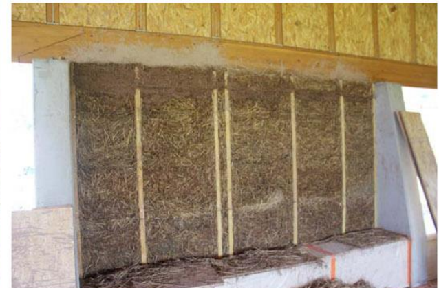
Vue de l'armature bois
