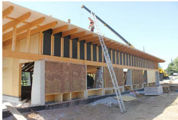
Chantier avant les enduits terre
