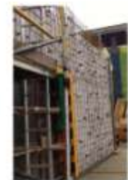
Après GBE® avoir positionné le second plan de banches
