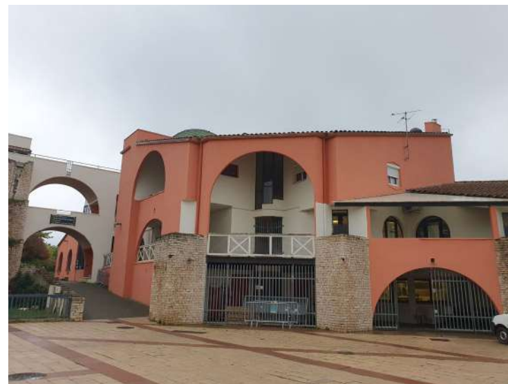
Vue depuis le NO sur l'élémentaire existante
