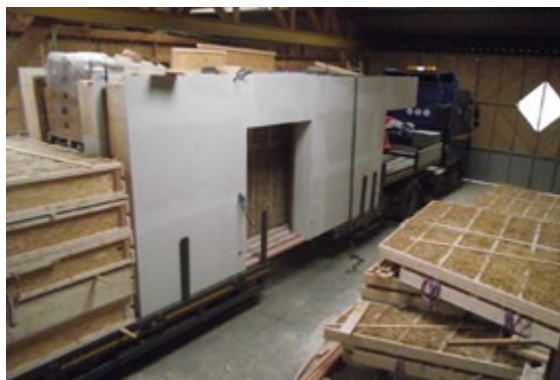
Préfabrication des caissons bois-paille en atelier - Photo © Cyril NATALI
