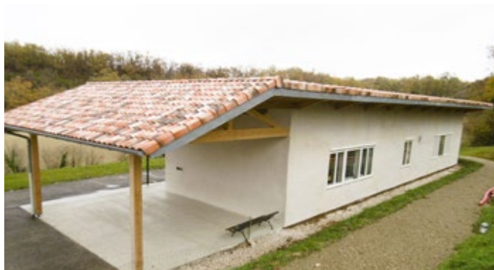
L'école en paille après enduit - Photo © CAUE 81
