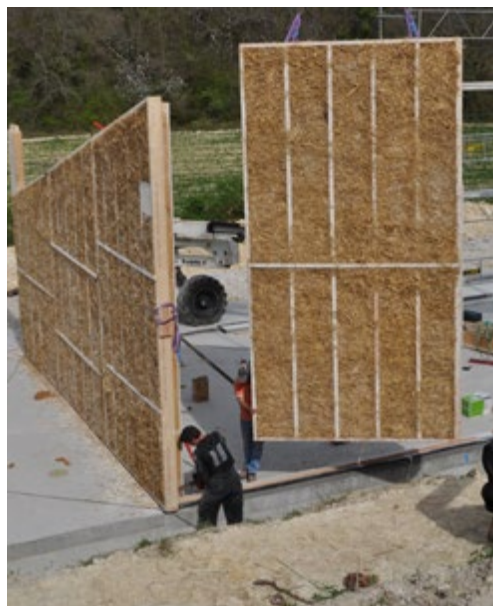
L'assemblage des caissons préfabriqués sur chantier - Photo © Boris BURZIO
