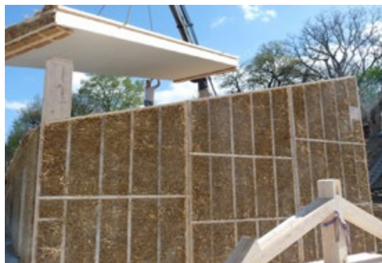
Assemblage des caissons sur chantier - Photos © Boris BURZIO
