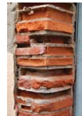
Joint imperméable : dégradation de la brique
