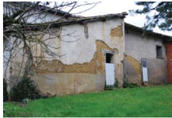
Décollement d'enduit imperméable
