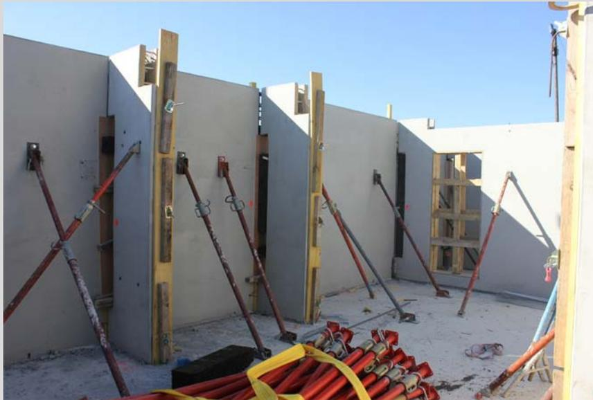
Assemblage des prémurs et réservations anti-pont thermique
