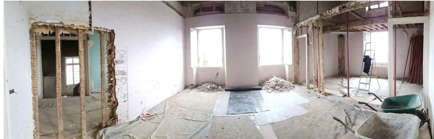
Ouverture des impostes de fenêtre et création d'une mezzanine en R+2 sur 70 m<sup>2</sup>
