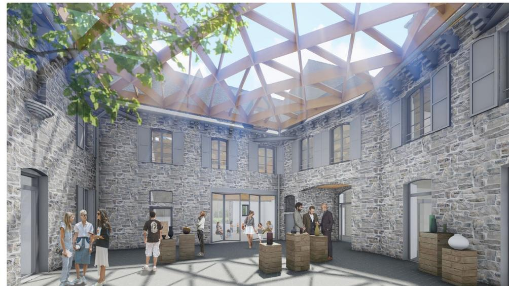
Passage d'une charpente métallique de la verrière en APS à une charpente bois en APD
