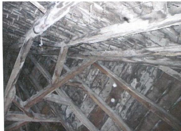
Charpente conservée et redressée sur une partie
