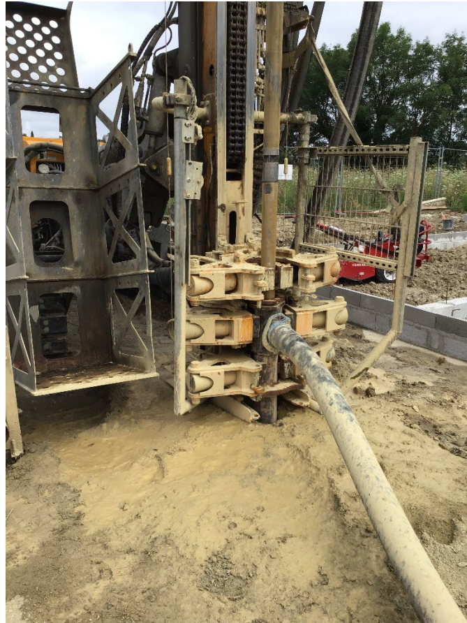
Forages géothermiques pour mise en place des sondes verticales
