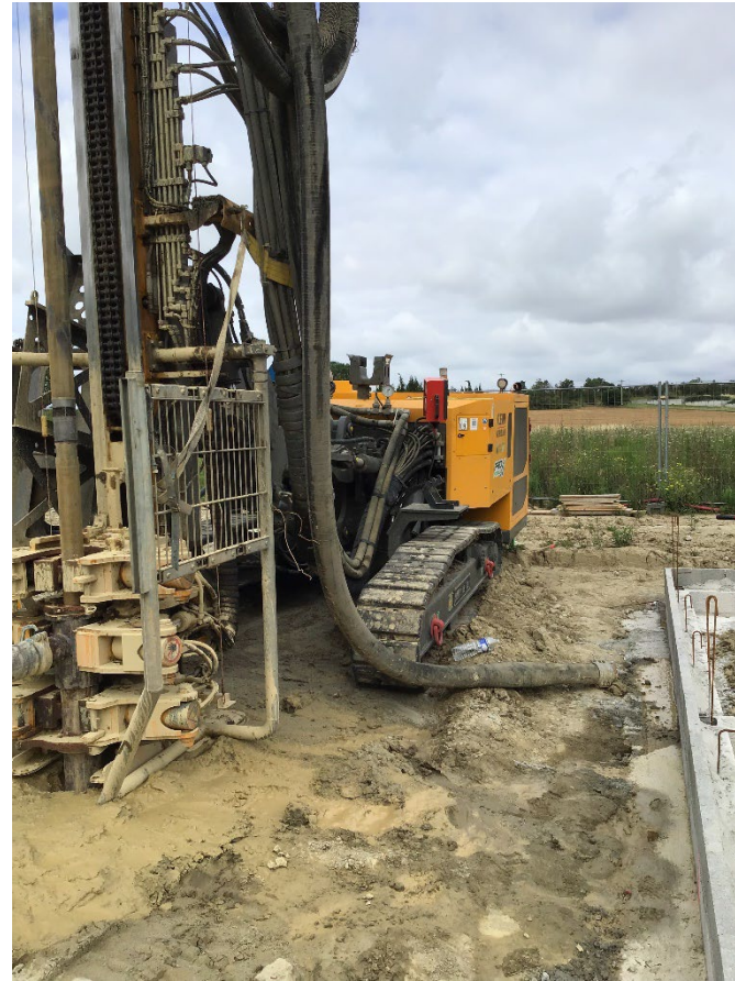
Forages géothermiques pour mise en place des sondes verticales
