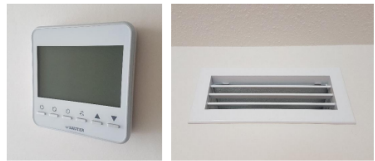
➤ Photos du thermostat digital et des grilles de diffusion
