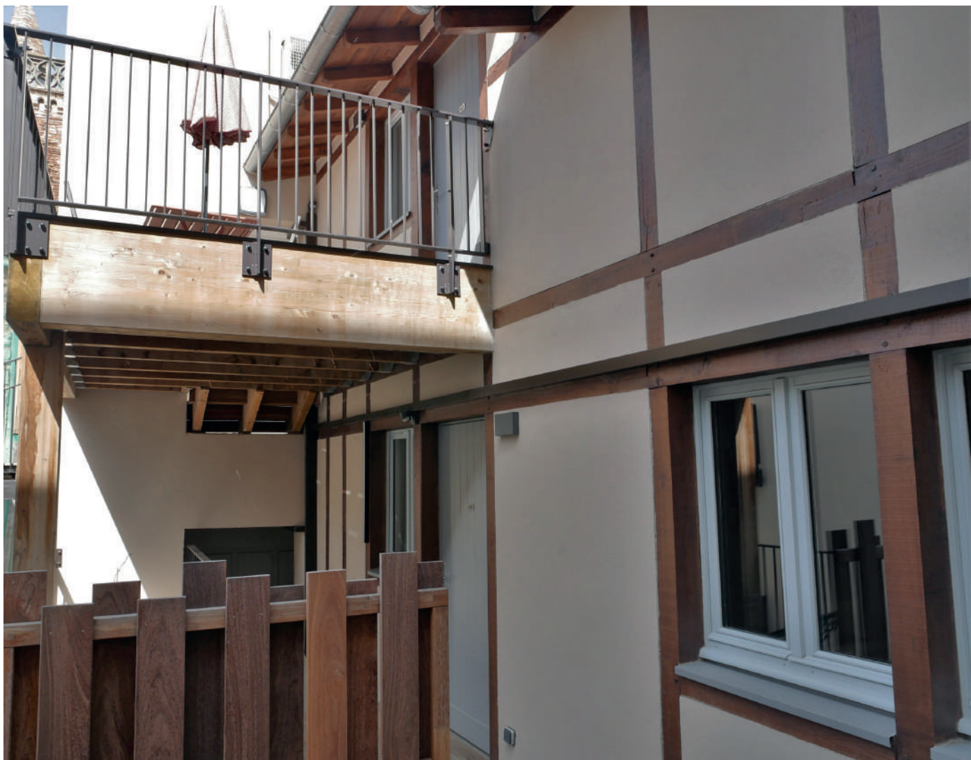
Vue sur colombage depuis la coursiè - Photo : Envirobot Occitanie
