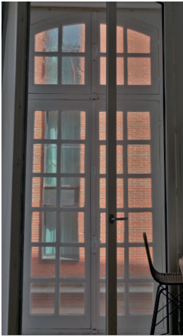
Menuiserie bois d'époque simple vitrage conservée, doublée au nu intérieur d'une menuiserie bois double vitrage Photo : Envirobot Occitanie
