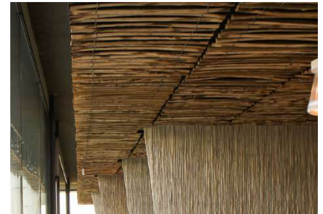
Exemple de faux-plafond en ganivelle: Lycée Marc Bloch, Sérignan. Architecte François Fontès. (photo Sophie Belloni-Vitou)
