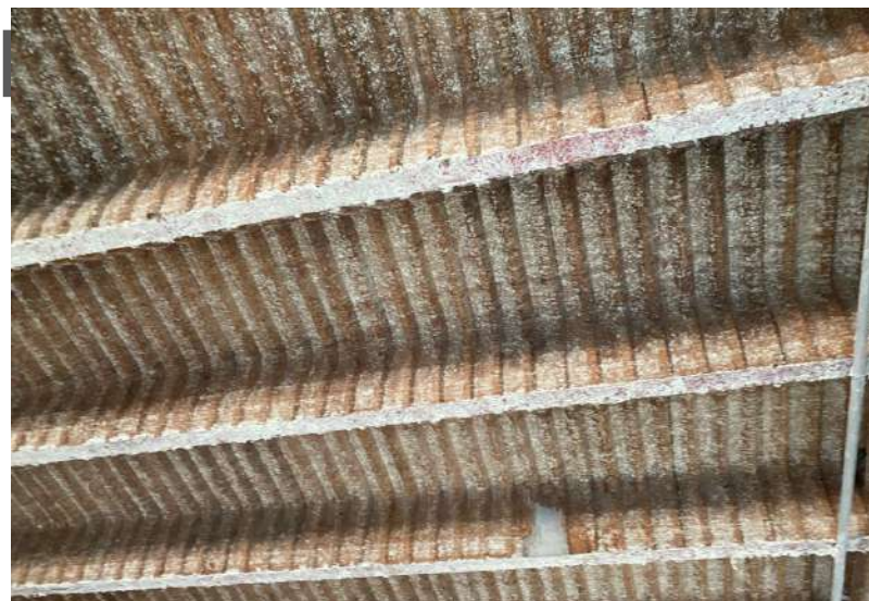
Stabilité au feu des planchers existants
