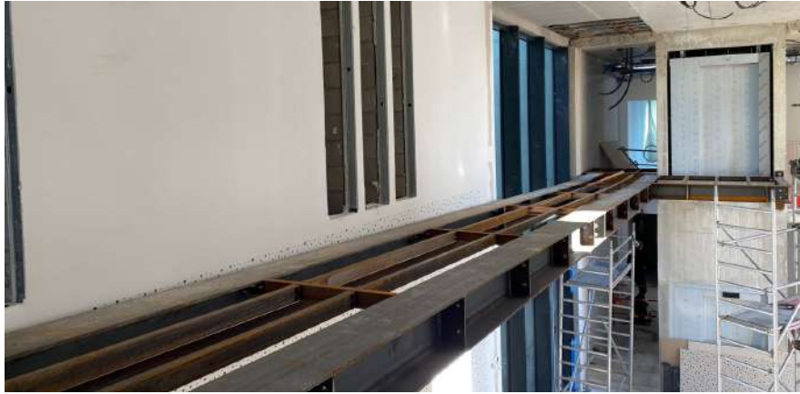
Passerelle entre l'existant et l'extension
