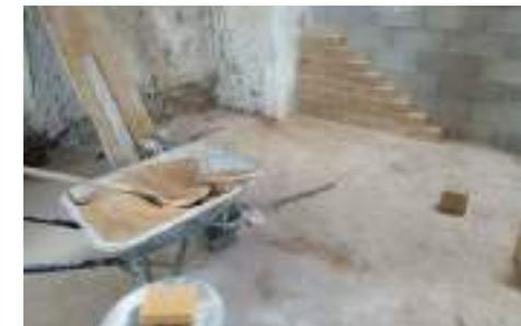
Cloisonnements en BTC – de Brique Technic Concept en 22 (à charge du GO)
