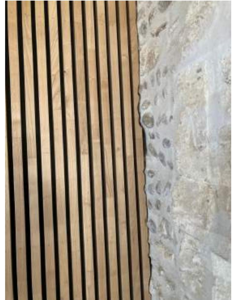
Parement intérieur « purebel » utilisé en contre-cloison // Bardages bois phonique
