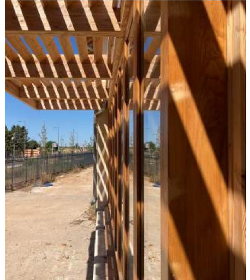
La plupart des menuiseries ont été réalisées en carrelets de châtaignier.
