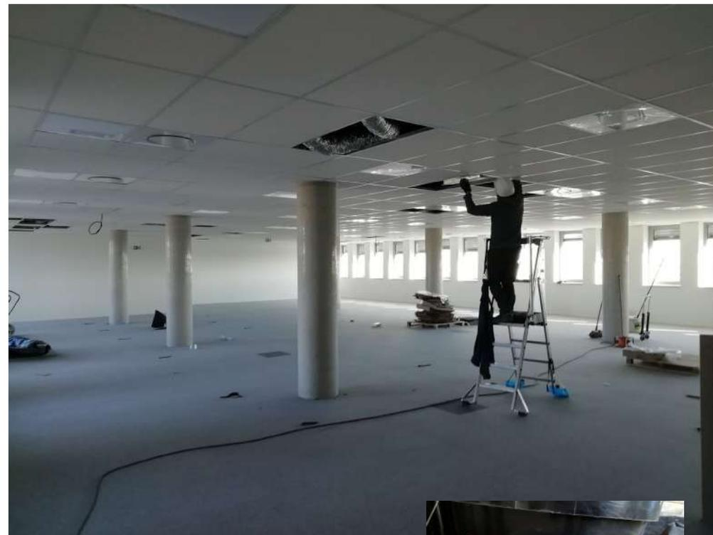
▲ Mise en place des moquettes BALSAN L480 A+ et GUT, faux-plafond ROCKFON Ekla A+ et luminaires LED
