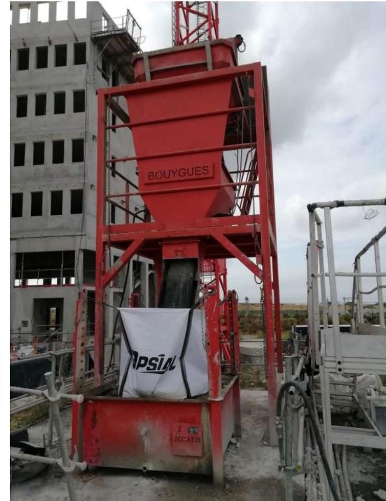
Plateforme de lavage des bennes béton
