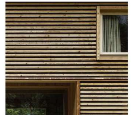
Bardage des façades protégées des intempéries et sous faces extérieures en tasseau de bois ajourés
