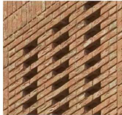
Claustra en brique de terre cuite pour les façades de l'abris vélo
