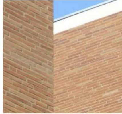
Soubassement et façades du RDC en briques de terre cuite
