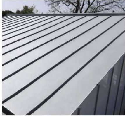
Bardage zinc sur les toitures et façades exposées aux intempéries
