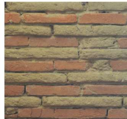
Murs mixtes terre crue/terre cuite pour les murs de la circulation principale. Solution reprenant des éléments de tradition constructive locale.
