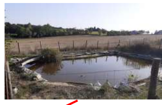
Mare neuve 95 m 3 , récupération EP et défense incendie
