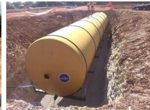
Mise en place de la cuve de récupération des eaux pluviales de 120 m<sup>3</sup>
