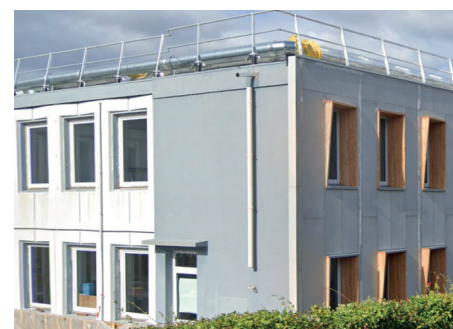
Façade avant travaux à gauche, après travaux à droite Image : Google Earth
