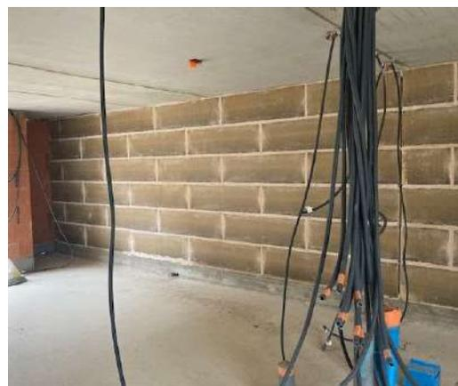
**ATEX de cas A permettant d'utiliser la Brique de terre crue en tant que maçonnerie porteuse obtenu en Octobre 2021.**
