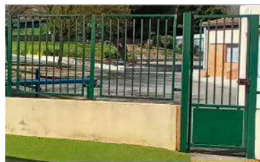
Clôtures et portails
