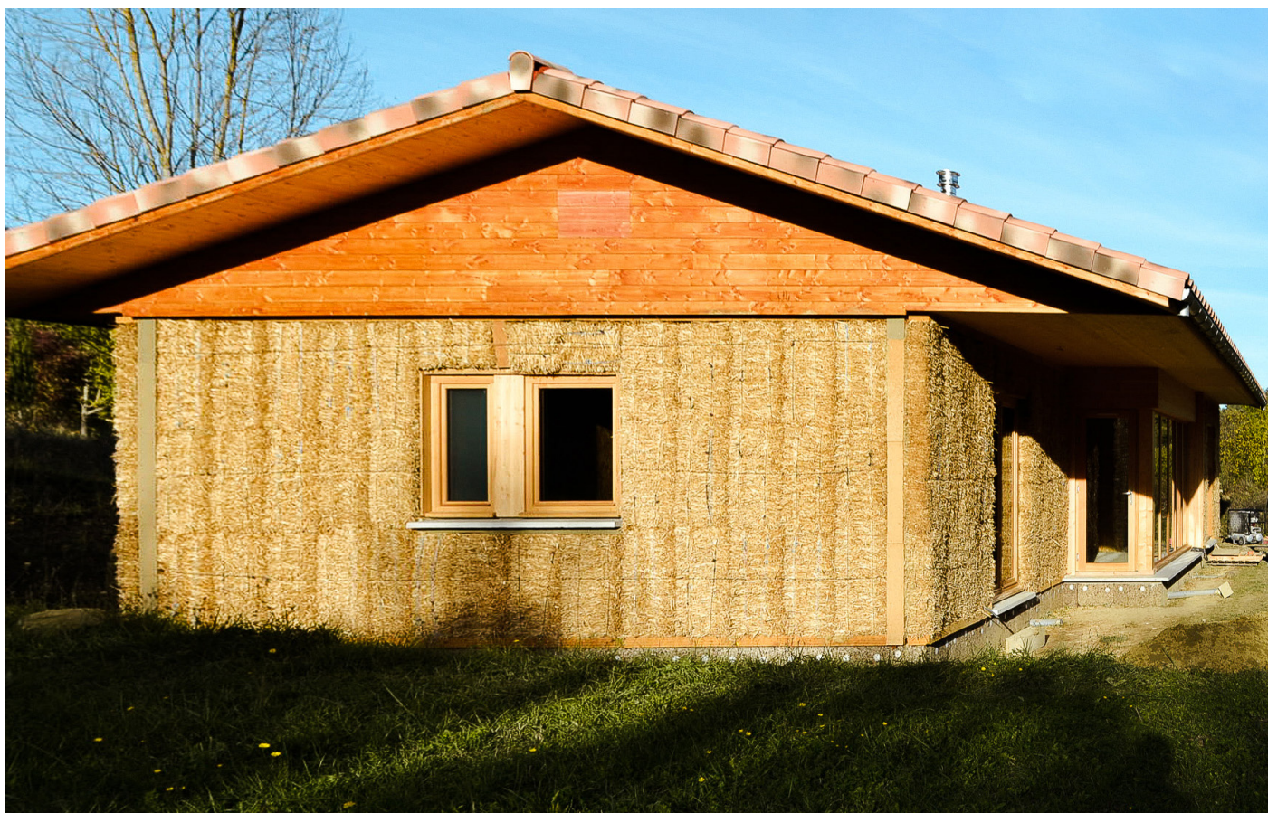
La mise en œuvre de la paille a été réalisée avec l'aide des stagiaires de Bâtipole, formés aux techniques de construction durable, encadrés par des professionnels confirmés. - Photo : Dirk Eberhard
