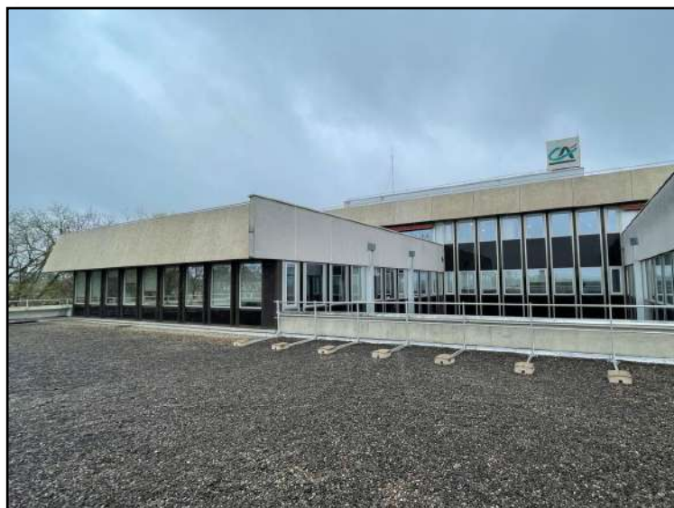
Architecture lourde avec de larges bandeaux horizontaux en béton préfabriqués soulignant de longues franges vitrées et d'importants ponts thermiques périphériques
