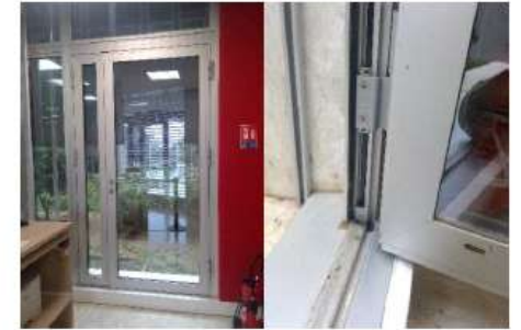
Fenêtre ensemble _TYPE A - aluminium - double vitrage - fixe 390*330cm
