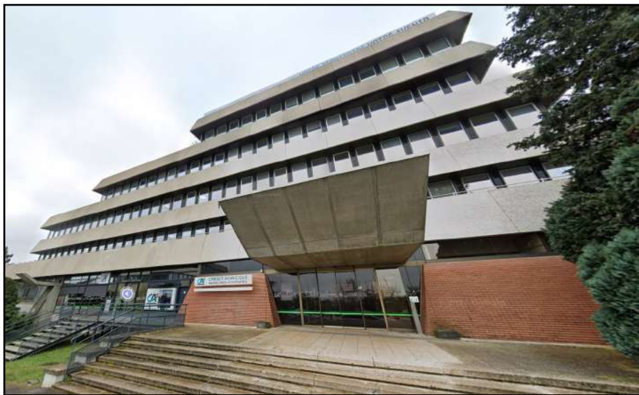
Architecture lourde avec de larges bandeaux horizontaux en béton préfabriqués soulignant de longues franges vitrées et d'importants ponts thermiques périphériques
