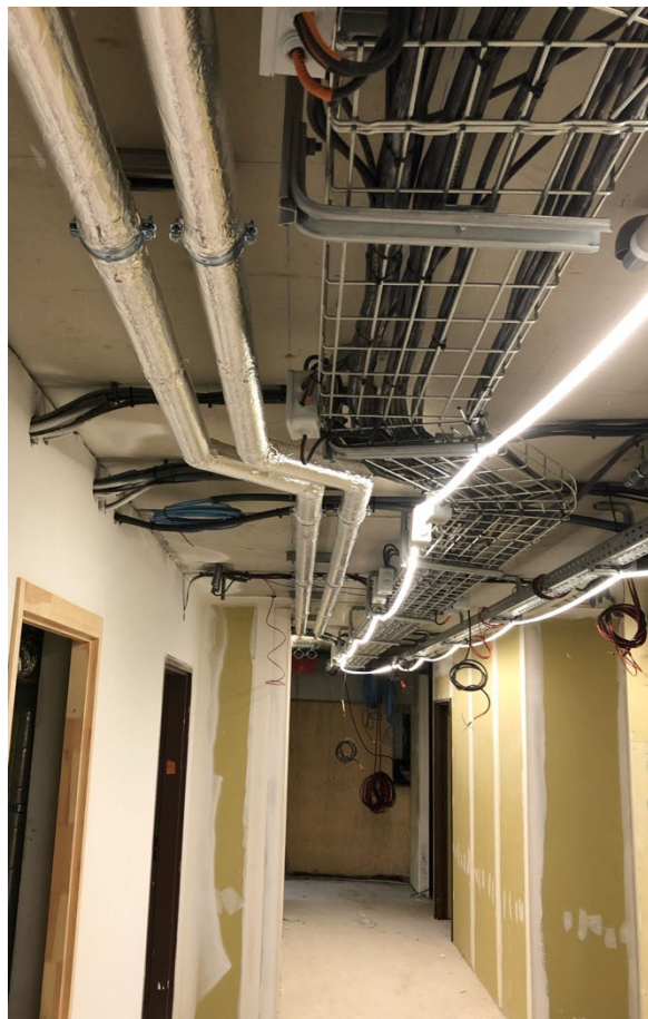
Plenum des couloirs
