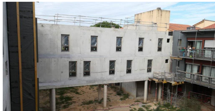
Passerelle entre l'existant et l'extension
