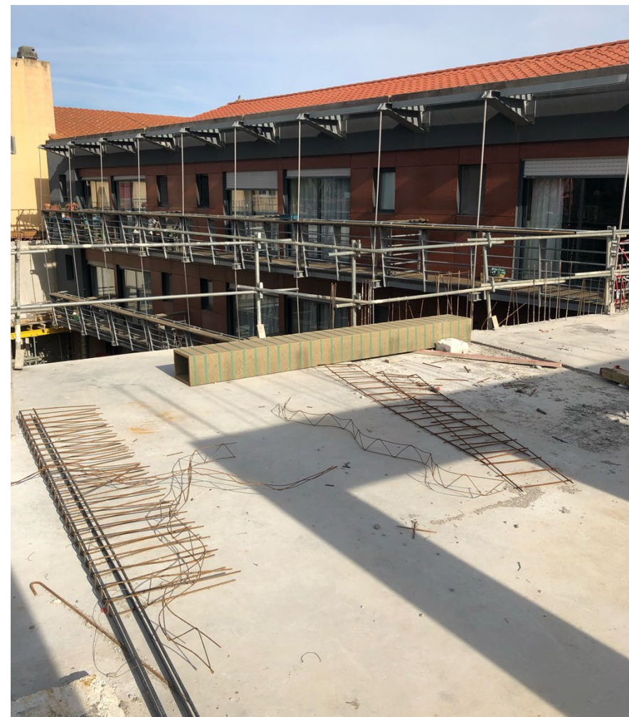
Chantier et existant (extension 2007)
