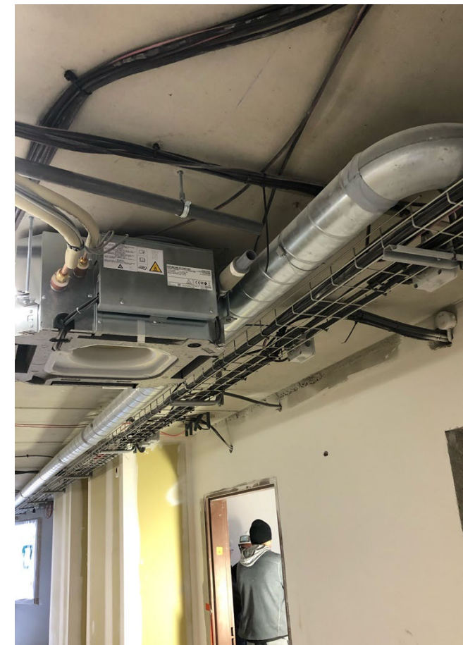
Réseaux de ventilation double-flux et pose des ventilo-convecteurs
