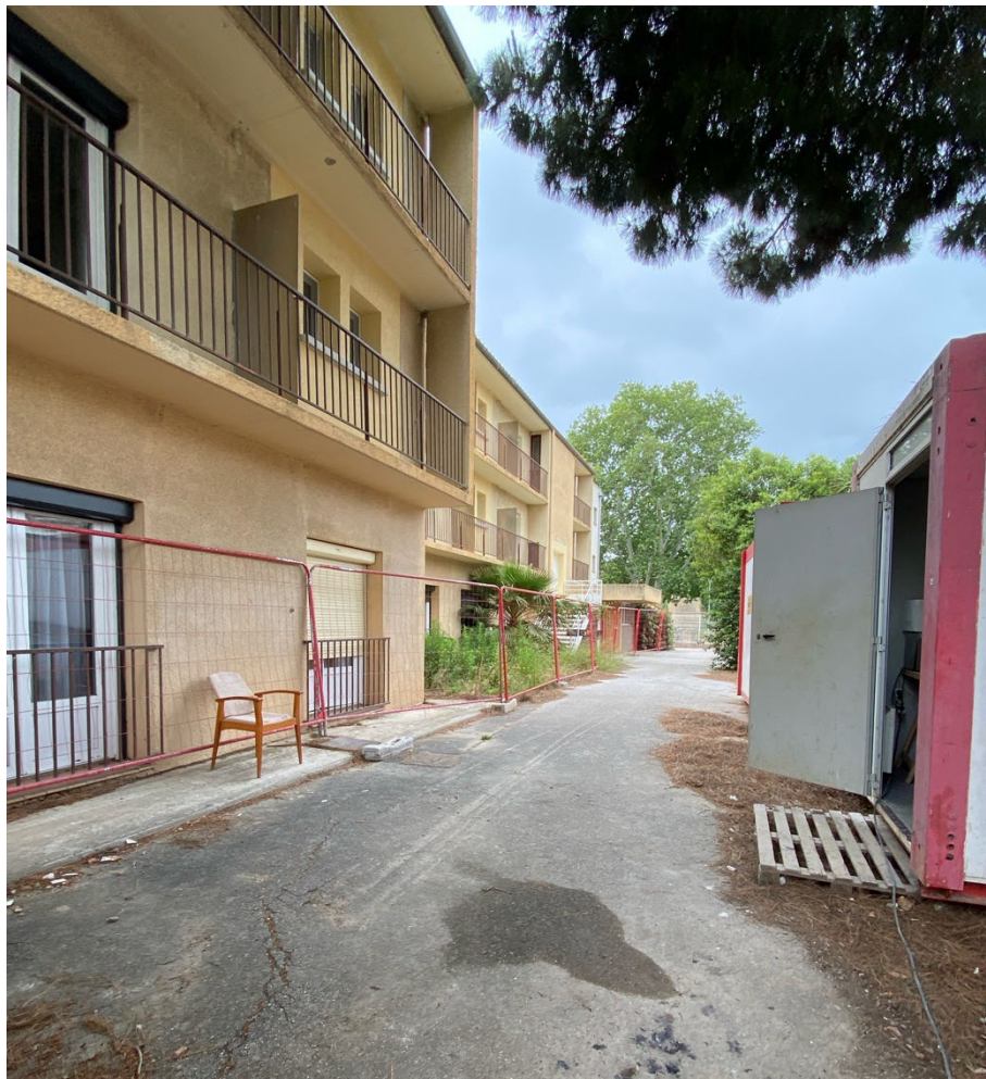
Installation de chantier (2024)
