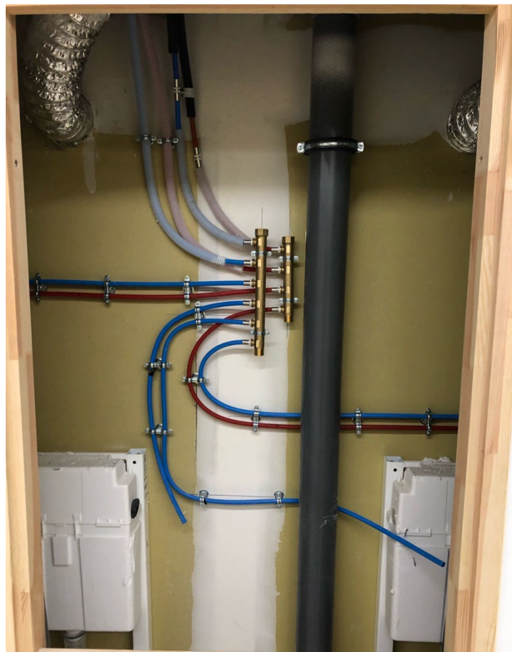
Gaines des salles de bains
