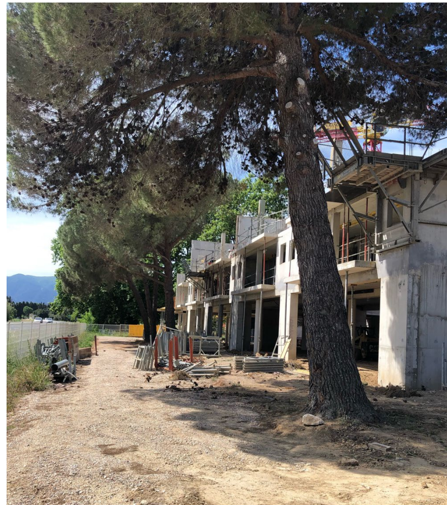
Chantier et existant (pins sur RD)
