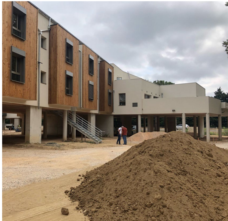
Apport terre végétale
