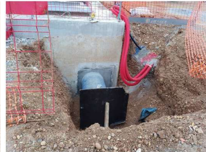
[26] - 11/10/2023 – pièges regards et chambres évités, fermeture correcte
