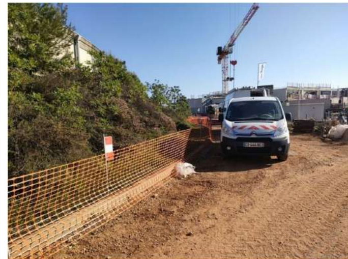
[9] - 19/04/2023 – Mise en défens des talus autour des réservoirs.
