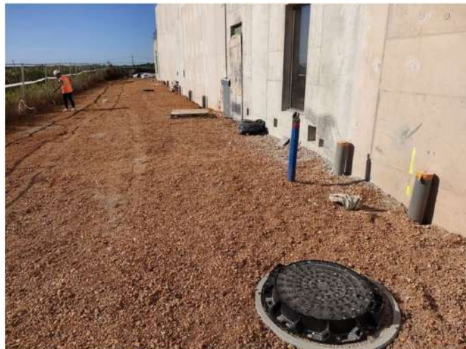
[5] - 08/08/2023 – Tampons fonte sur les regards.
