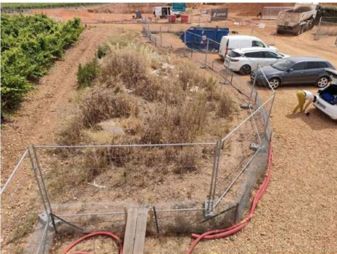
[7] - 16/06/2022 – Emprise base-vie : barrière Heras et grillage petite faune en place.
