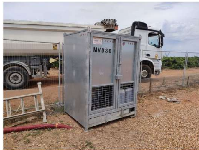
[16] - 30/06/2022 – Abri de stockage avec bac de rétention pour les produits polluants.
