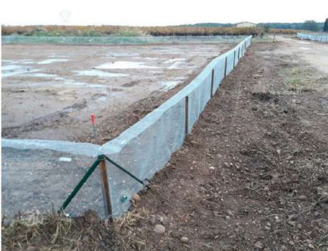
[2] - 24/11/2021 – Grillage petite faune en périphérie de la base-vie et zone de stockage (vue générale).
