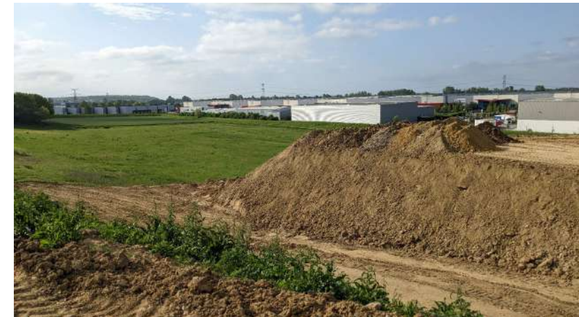
Evacuation terres sur terrain mitoyen
