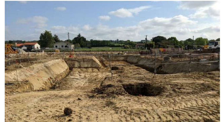
Terrassement vide sanitaire restauration
