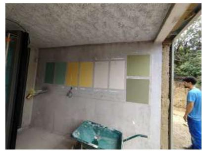
Isolation laine de roche sous bardage + test colométrie
