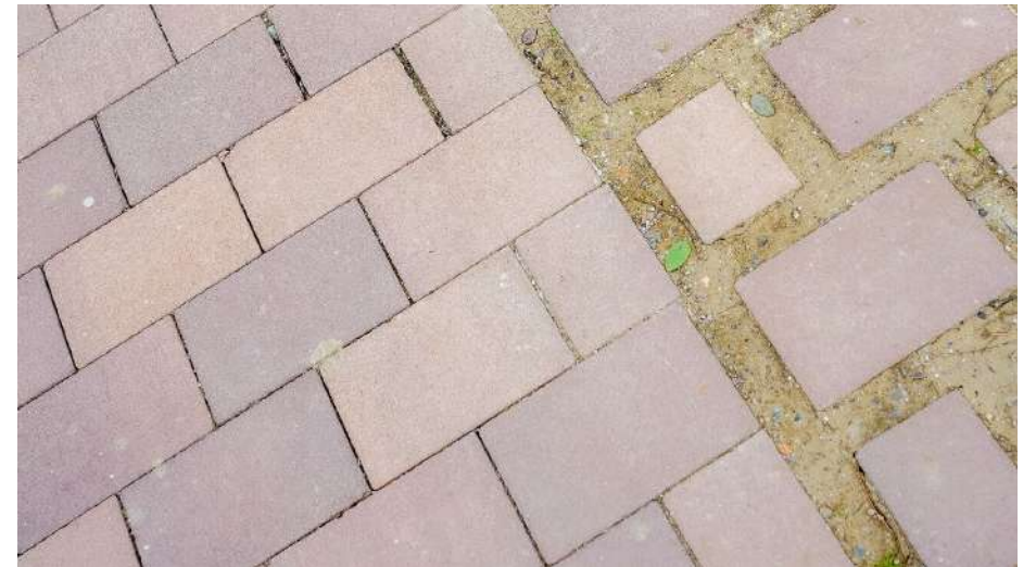
Pavé bicouche, incorporation 20 % d'agrégats recyclés originaires d'agrégats sidérurgiques
