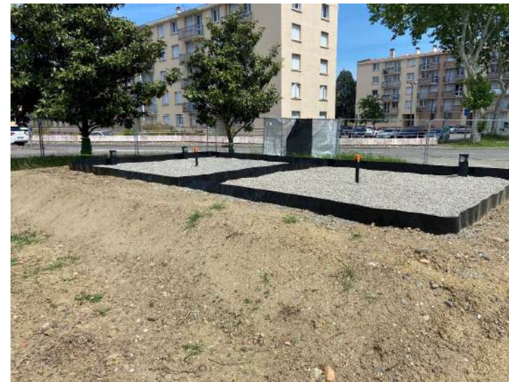
Réalisation en cours sur chantier MTE
