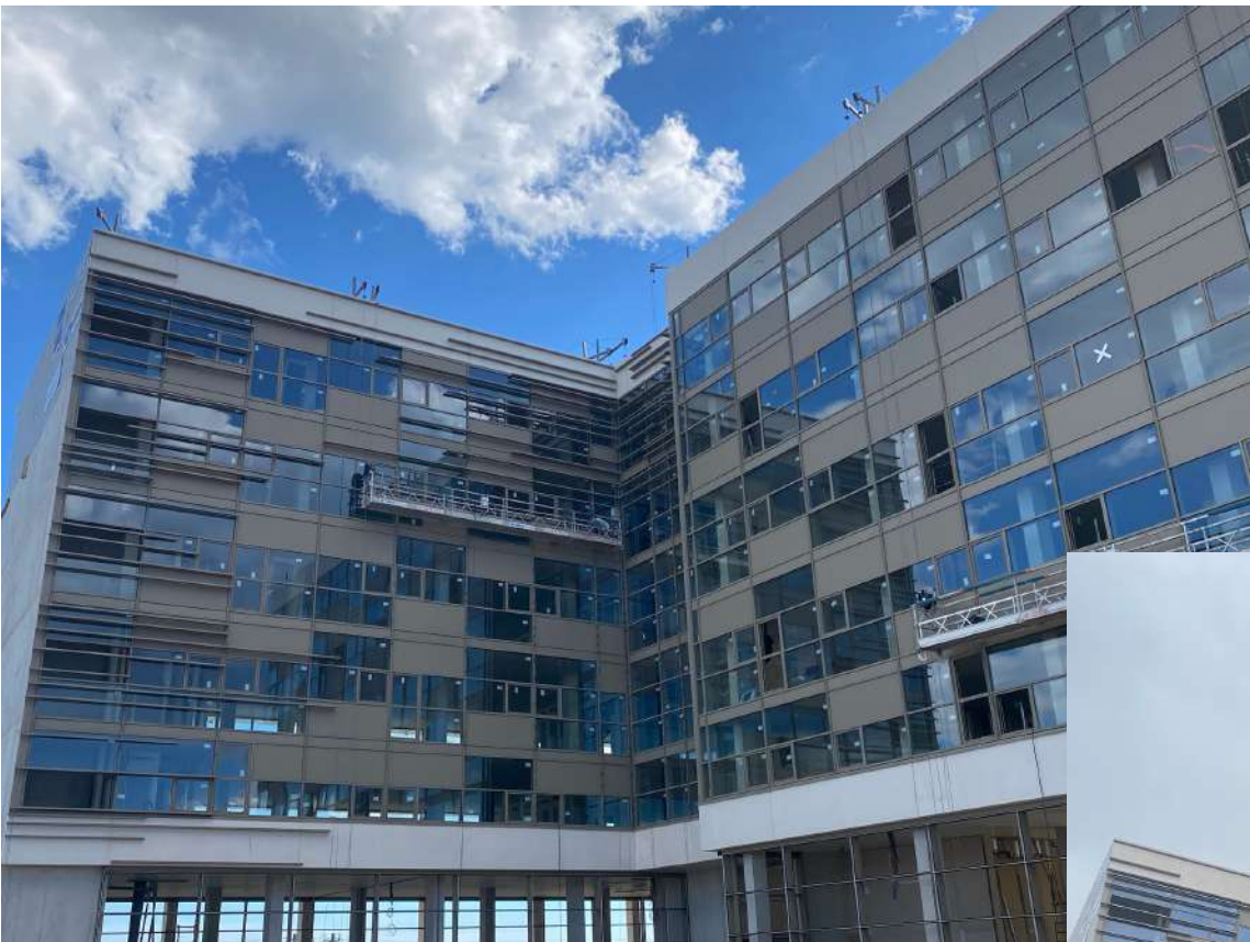
Façade N&E - Septembre 2022
