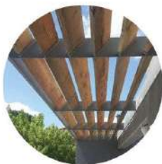
Casquettes fixes horizontales SUD lames bois orientées
