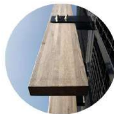
Protection verticale Ouest lames bois
