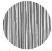
Socle béton matricé Socle RDC
