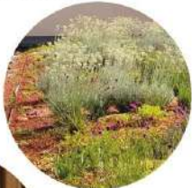
Toiture terrasse semi intensive
