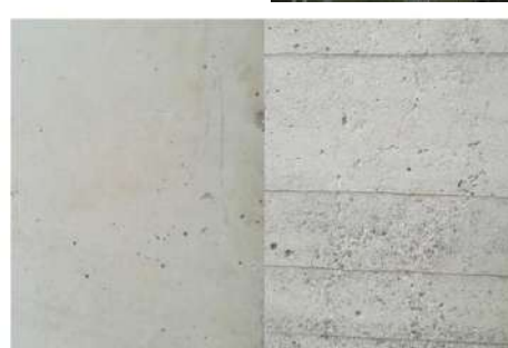
Mur avant sablage
