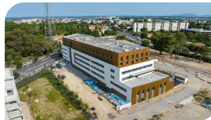
Photo par Drone-OPS
