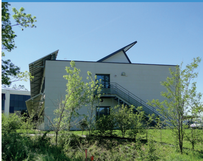
Un bâtiment compact et bien orienté.
