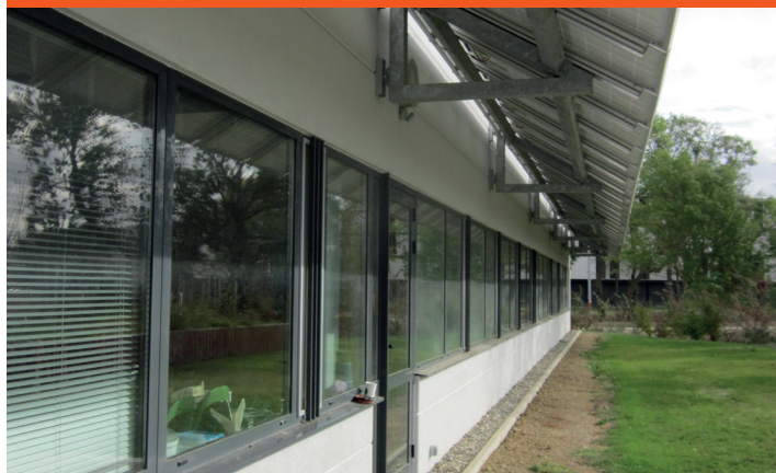
356 m 2 de panneaux photovoltaïques ont été installés.
