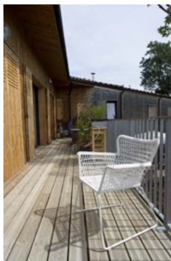
Le balcon d'un simplex côté sud. Photo © Philippe Guionie
