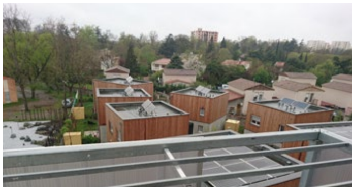
Densité et diversité : collectif positionné en tampon sur la rue et maisons individuelles en continuité de la zone pavillonnaire - Photo © CAUE 31
