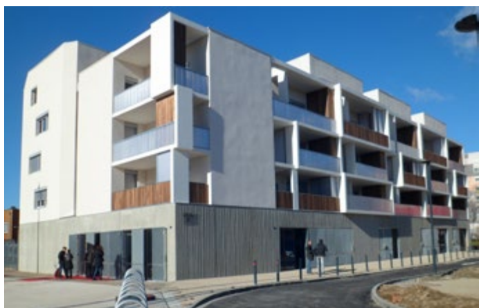
Volumétrie sur rue compacte et alternance de pleins et de vides - Photo © Lieux Communs
