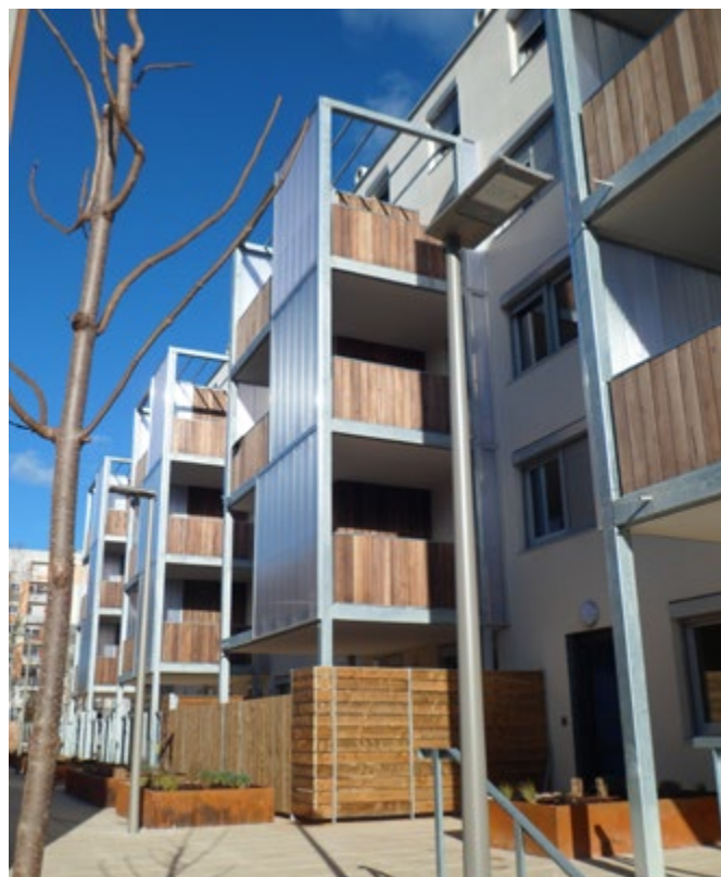
Façade du collectif côté cœur d'îlot - Photo © Lieux Communs
