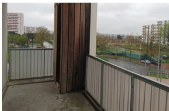
Profondeur des balcons protégeant les ouvertures en façade et offrant des espaces de rangement - Photo © CAUE 31
