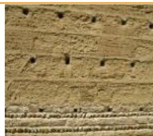
**La bauge** est une technique de construction qui consiste en l'édification de murs massifs, souvent porteurs, avec un mélange de terre, d'eau et de fibres végétales, voire animales, et mis en œuvre par empilement de motte à l'état plastique, généralement sans l'aide de coffrage.
