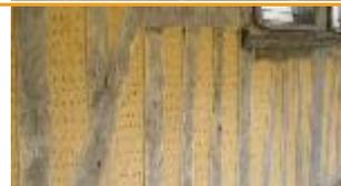
**Le terre-paille** est un système constructif basé sur une ossature bois intégrée dans un mélange de terre et de paille, de densité inférieure à 800kg/m<sup>3</sup>, tassé entre des banches.
