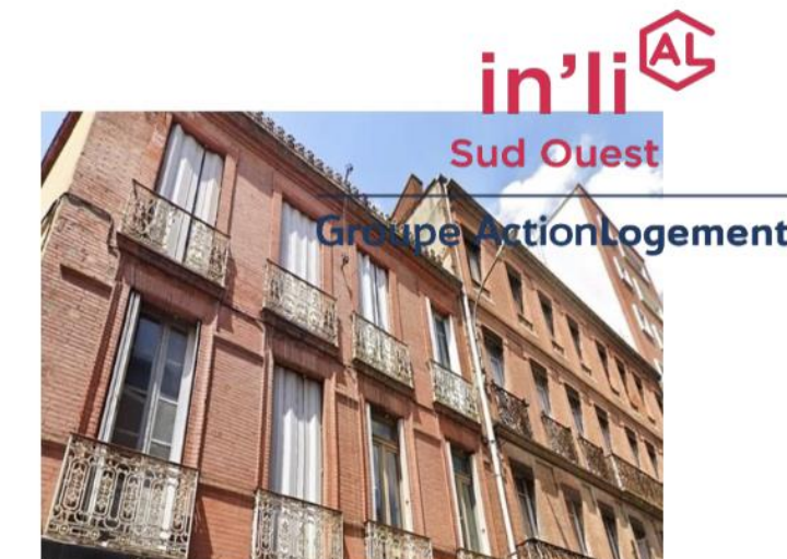
REHABILITATION LOGEMENT RUE DENFERT ROCHEREAU
