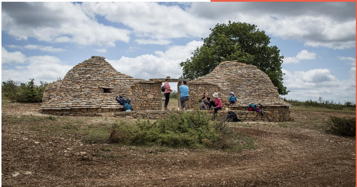
Super Cayrou à Gréalou (Lot), dans le Parc naturel régional des Causses du Quercy - Architectes : Encore Heureux © Encore Heureux
