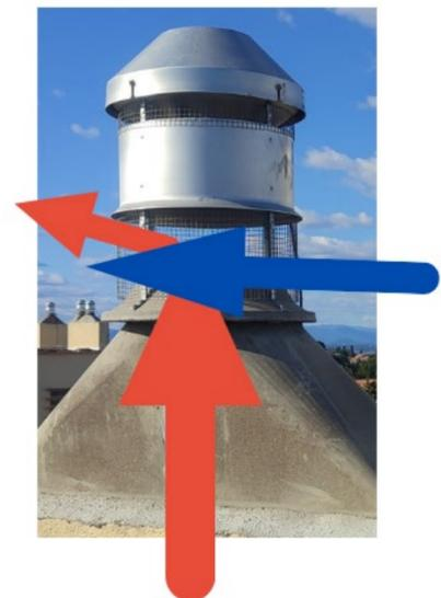
**Un tirage éolien** : La forme du système en bout de conduit crée un effet venturi qui augmente la vitesse en bout de colonne. Couplée avec le tirage thermique, la dépression dans le conduit est augmentée, augmentant de fait la vitesse d'évacuation de l'air.
