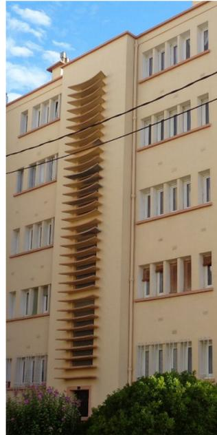
Les façades des bâtiments sont marquées par les escaliers des parties communes. Pour **conserver l'identité architecturale** du bâtiment et **limiter la complexité** de la pose de l'isolation par l'extérieur, il a été décidé de ne pas les isoler.
