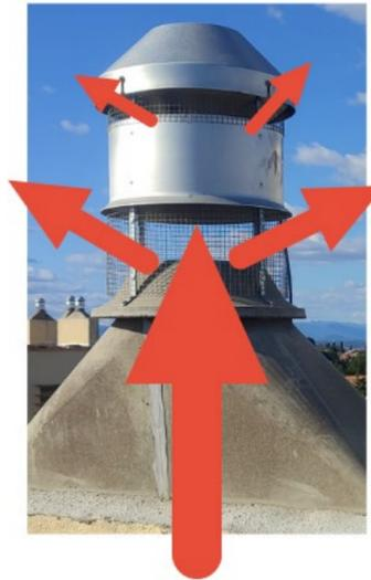
**Un tirage thermique** : L'air intérieur qui rentre dans la colonne de ventilation, étant plus chaud et moins dense que l'air extérieur entrant en bas de la colonne, est poussé vers le haut du conduit. Cela crée une dépression et augmente son aspiration vers l'extérieur. On surnomme ce phénomène « l'effet cheminée ». Plus l'immeuble est grand, plus la puissance de tirage est élevée.
