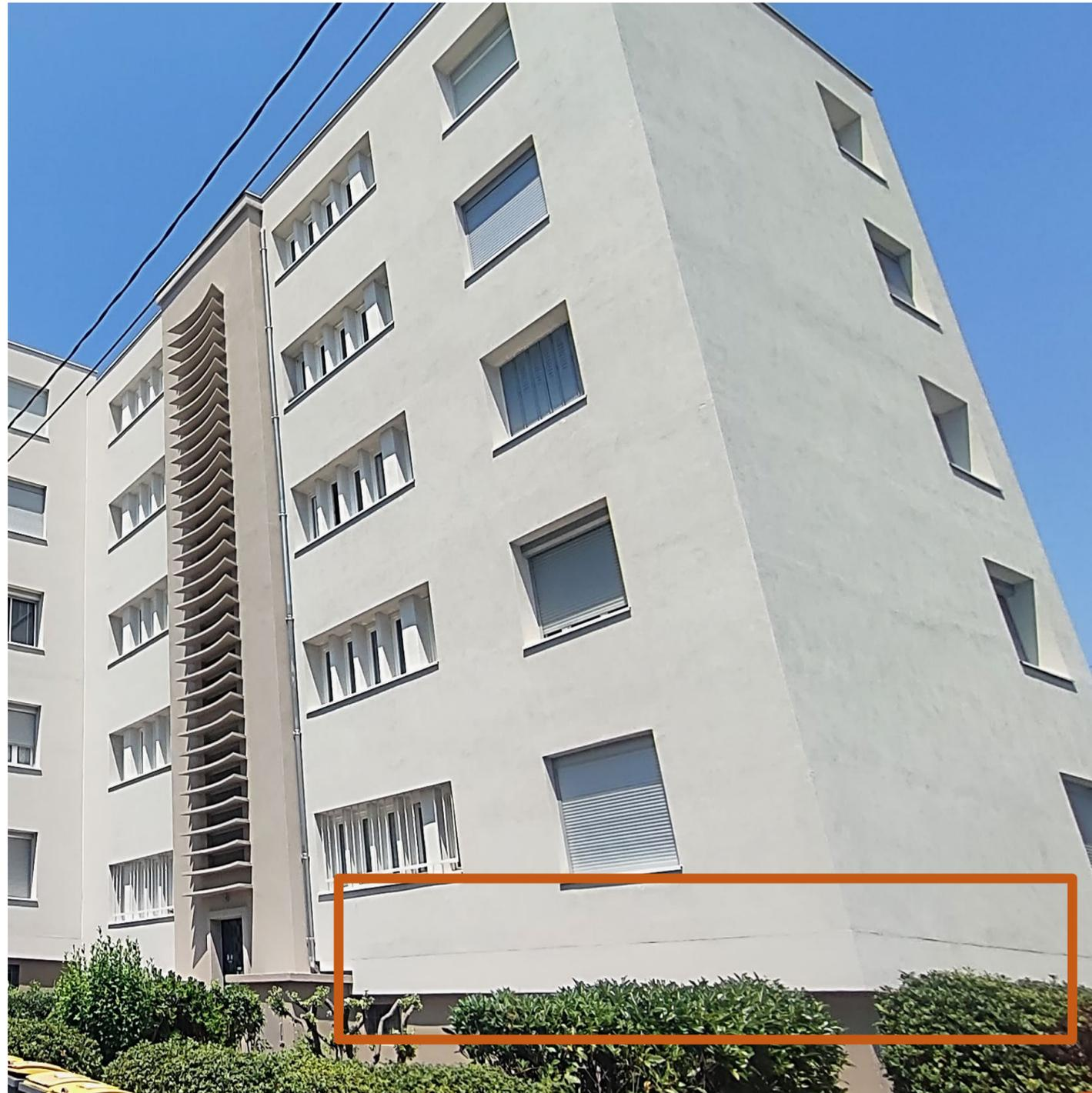
L'entreprise de pose de l'isolation thermique par l'extérieur n'as pas pris en compte le décalage des hauteurs de dalle entre les bâtiments. Sur le bâtiment 2, l'ITE s'arrêtait en haut de la dalle, il y avait donc un **fort pont thermique créé par l'absence de continuité entre l'isolation du mur extérieur et du plancher bas.**
