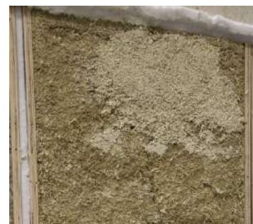
Photo 7 : béton de chanvre en fin de reprise avec rebouchage de la partie décollée.
