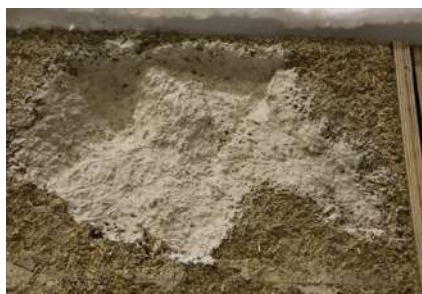
Photo 6 : béton de chanvre humidifié avec un coulis de liant de même composition que celui ayant servi à faire le béton de chanvre initialement.
