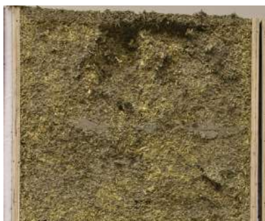
Photo 5 : béton de chanvre non homogène avec décollement ponctuel.
