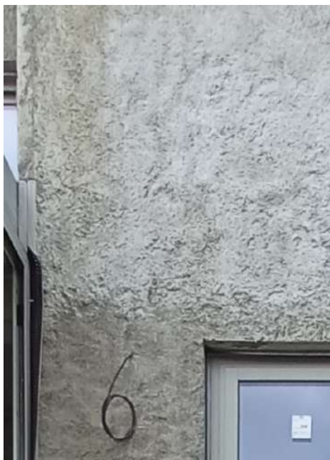
Photo 1 : béton de chanvre en cours de séchage. Zone plus sèche sur le haut et plus humide sur le bas.
