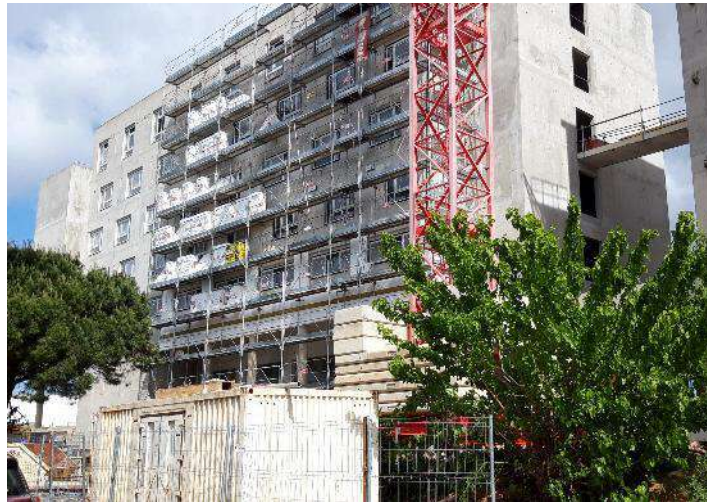
Isolation extérieure en polystyrène
