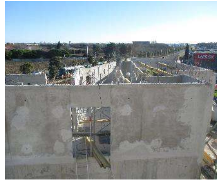
Voiles des niveaux supérieurs
