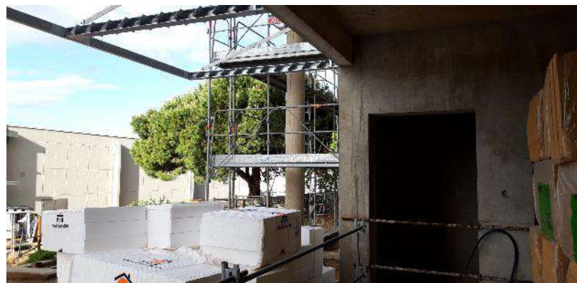
Installation des brise soleil fixes en RDC
