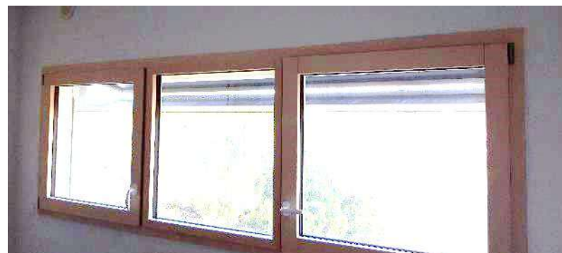
Menuiseries bois/aluminium dans logements
