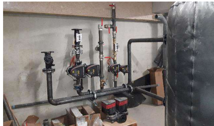
Equipements dans la sous-station
