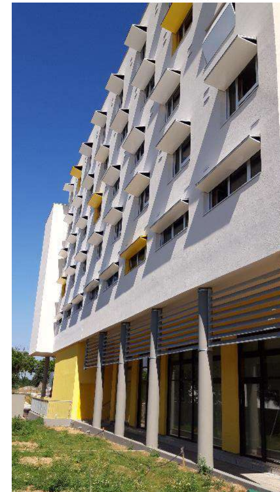
Brise-soleil fixes et relevables façade Sud
