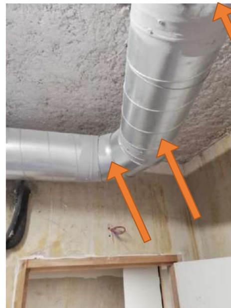
Bâtiment B : Raccordements entre conduits
