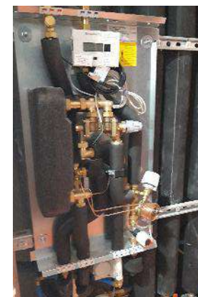
Module thermique d'appartement
