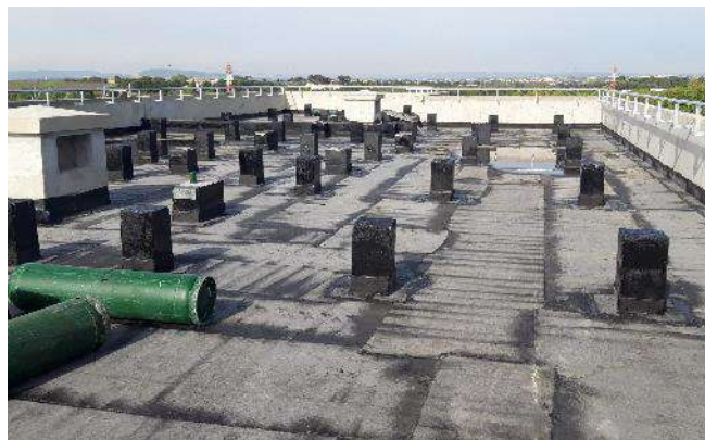
Etanchéité en bicouche bitumineux sur le bâtiment A
