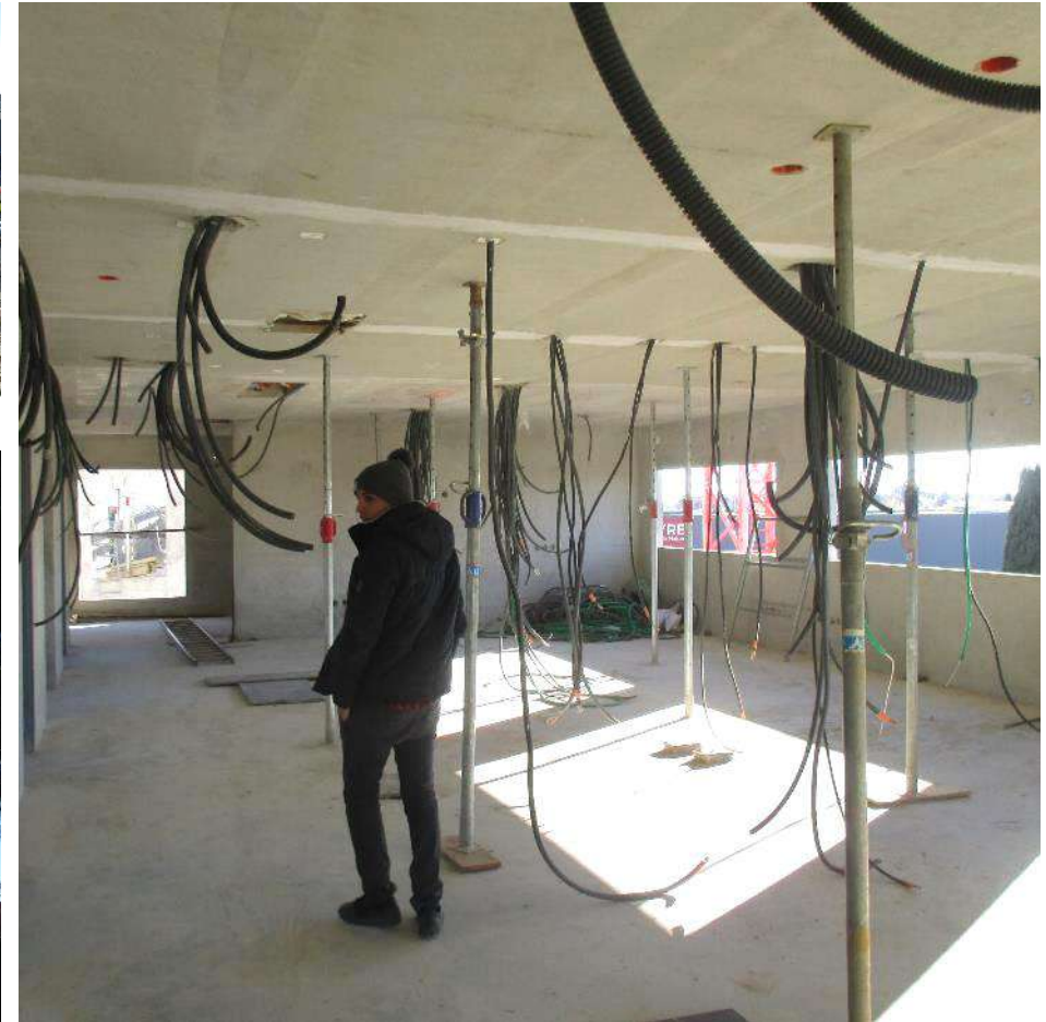
Réserves et tuyauteries en attente
