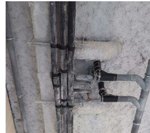
Flocage des planchers hauts des parkings
