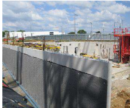
Voiles du sous-sol avec drains
