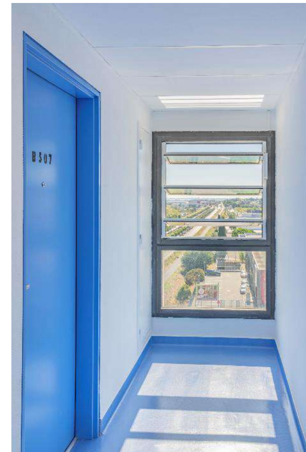
Menuiserie aluminium avec ventelles dans circulations
