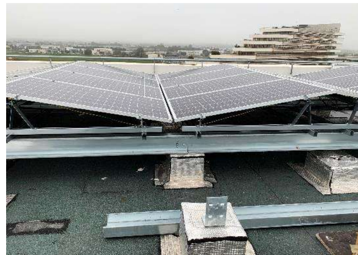
Panneaux photovoltaïques sur le bâtiment A
