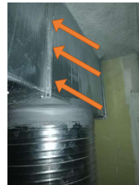
Bâtiment A : Raccordements entre conduits
