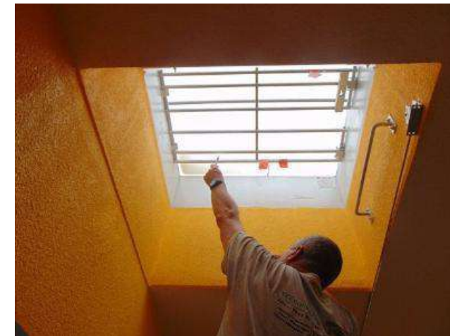
R+5 bâtiments A et B, skydomes
