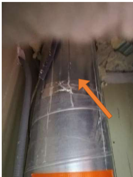
Bâtiment B : Raccordements entre conduits
