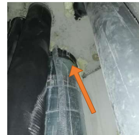
Bâtiment A : Raccordements entre conduits
