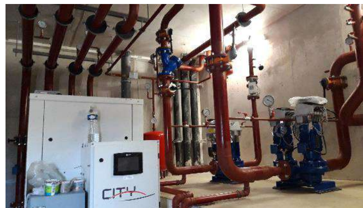
Equipements dans la sous-station
