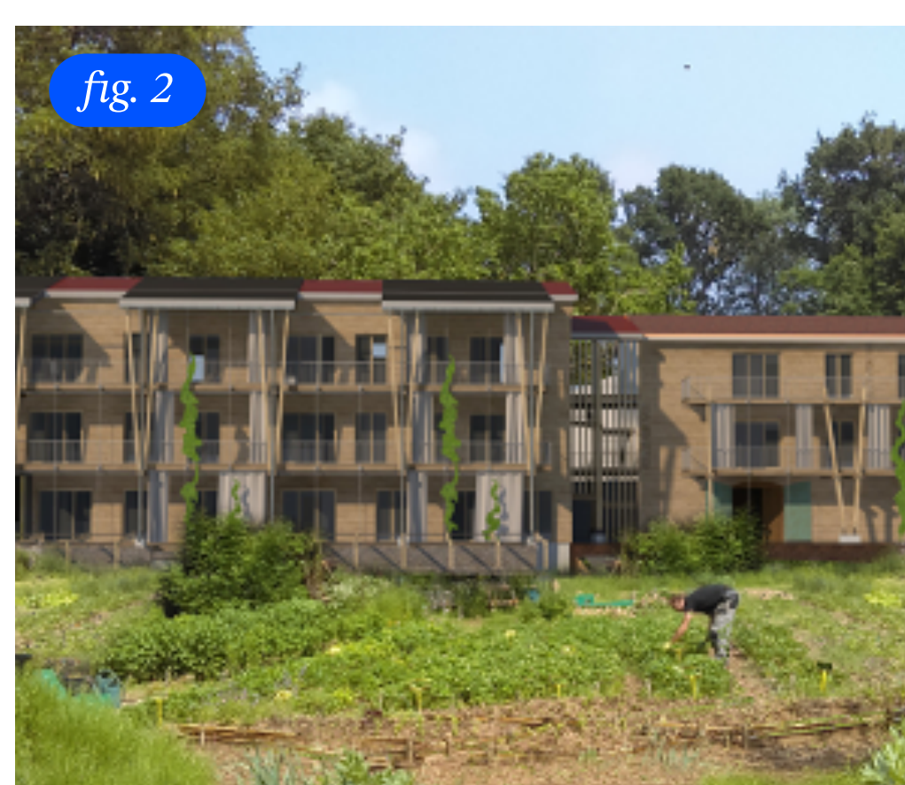
© DATCHA architectes - Alexandre Neagu et Thomas Nougaret — Construction de 20 logements participatifs - Maître d'ouvrage : Coopérative Îlot vert de la Soulondre.
