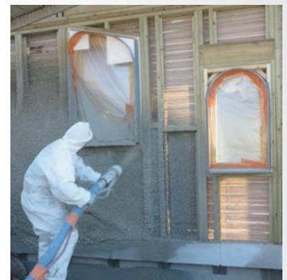
PROJECTION DE BÉTON DE CHANVRE SUR LE CHANTIER DE GOUR DE L'ARCHE À PÉRIGUEUX
